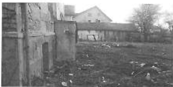
Construcții pe amplasament
